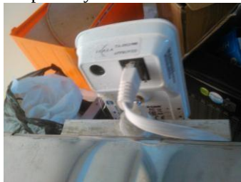
Gambar 13 Kabel UTP tersambung dengan Kamera
