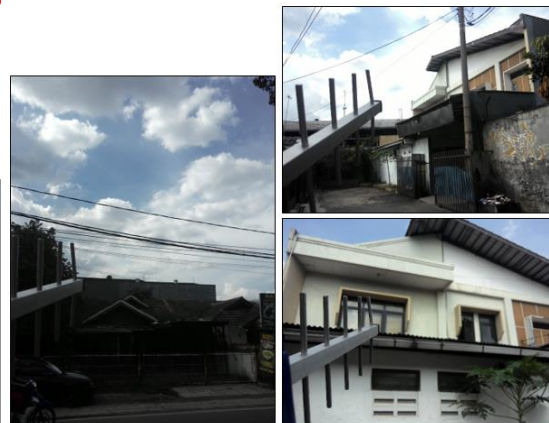
Gambar 3.2.5 Pemindaian frekuensi dengan menggunakan antenna yagi
