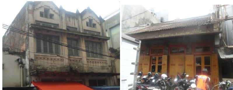
Gambar 3.8 Bangunan ruko tua sekitar pasar baru selatan bergaya Belanda
