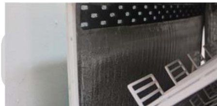
Gambar 19. Detail ventilasi di akses pintu
