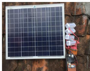
Gambar 5. Sistem Pengisian Baterai
