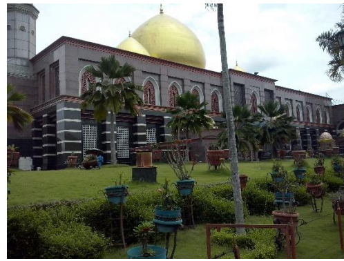
Gb 2.37 Fasad Masjid Dian Al-Mahri (Sumber: Dokumentasi pribadi,2016)
