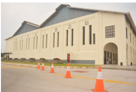
Gambar 3. Bangunan Wisata De Tjolomadoe (Sumber : Dokumentasi Penulis)
