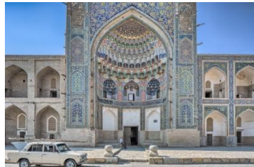
Gambar 3.2.c : Muqarnas pada masjid di Bukhara, Uzbekistan Sumber : Arsitag.com/ arsitektur Islam (2019)
