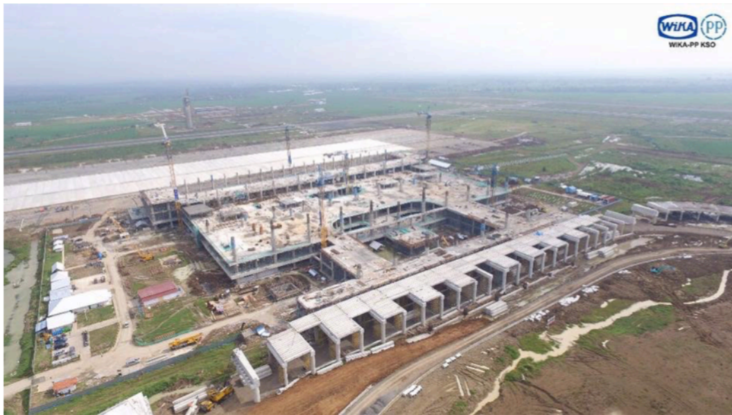
Gambar 1.4 Pembangunan Terminal Utama Bandarudara Internasional Jawa Barat
