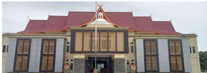
Gambar 1 Bangunan Kantor Kecamatan Bandar Laksamana
