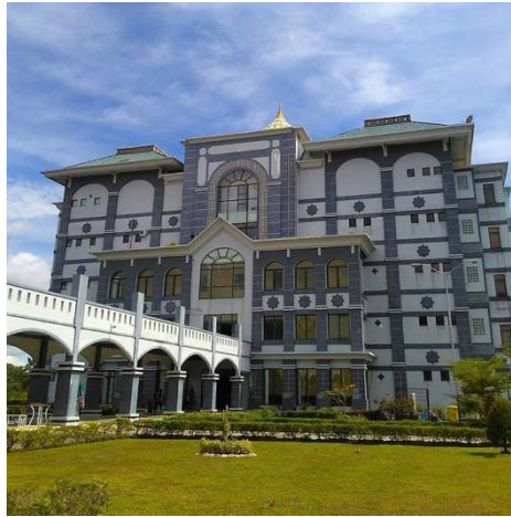
Gambar 1.4 Gedung Universitas Islam Negeri Sultan Syarif Kasim Riau
