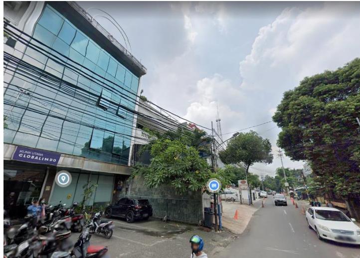
Gambar 3. 9 Fasad Bangunan Klinik Utama Globalindo
