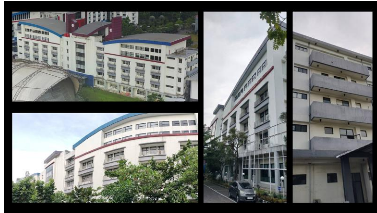
Gambar 3.2 Gambar Tiap Sisi Gedung Sebatik
