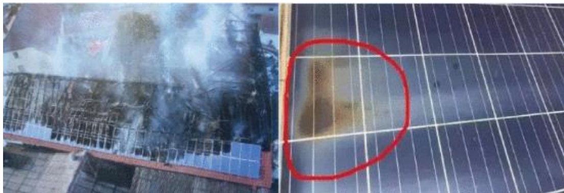
Gambar 1.2 Kebakaran pada panel surya [14]
