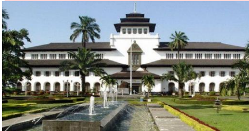
Gambar 5 Tampak depan Gedung Sate
