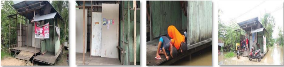
Gambar 1. Bangunan Posyandu Kenangan
