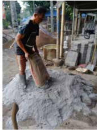
Proses pencampuran abu dedaunan + pasir + semen
