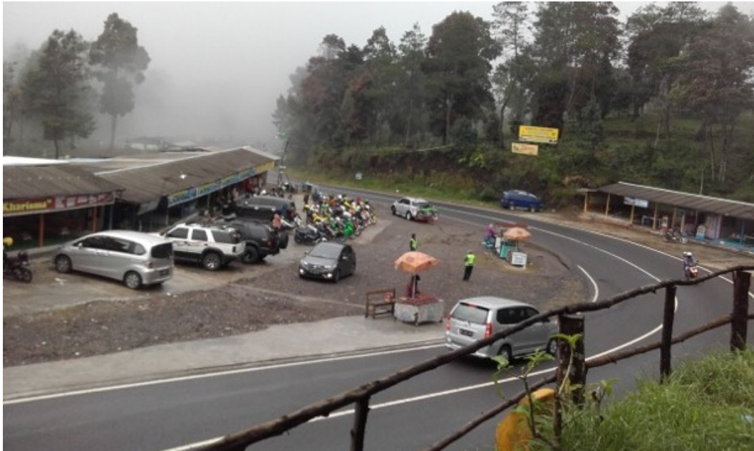
Gambar 1. 6 Pelebaran Jalan di Tawangmangu
