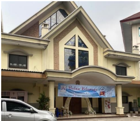
Gambar 3 Fasad Depan Bangunan (Sumber: Data Pribadi)
