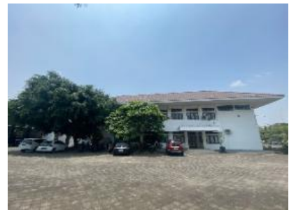
Gambar 1. 4 Tampak Sisi Kantor Sumber: Dokumentasi Pribadi
