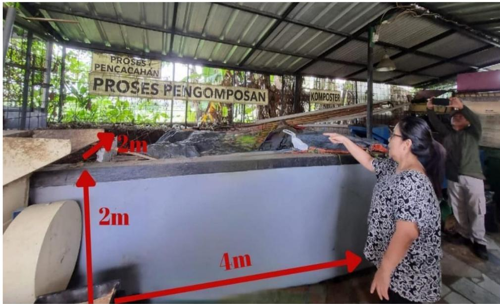
Gambar 1.5 Bak Pengolahan Sampah/Komposter Kapasitas 6 Ton
