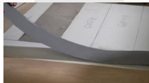
Gambar 8. Proses pemasangan hampelas Sumber: Penulis, 2024
