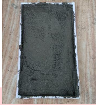
Gambar 15. Pemasangan fiber glass tape Sumber: Penulis, 2024
