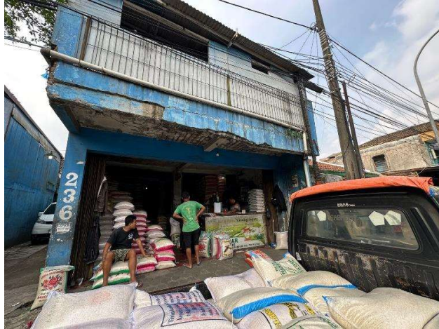
Gambar I.5 Kondisi Eksisting PD Jembar
