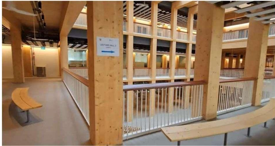
Gambar 1. 3 Kondisi Penggunaan Lampu Pada Gedung Gaia
