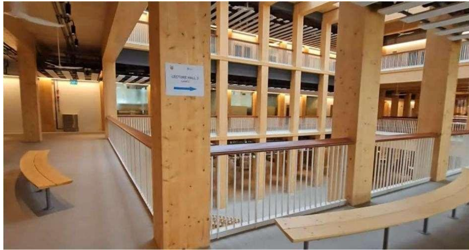
Gambar 1. 3 Kondisi Penggunaan Lampu Pada Gedung Gaia
