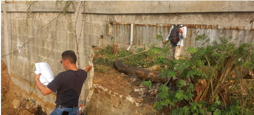
Gambar I. 3 Project Manager Kontraktor Tidak Menerapkan Keselamatan dan Kesehatan Kerja (K3)
