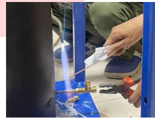
GAMBAR 7 (Pengelasan Pipa)
