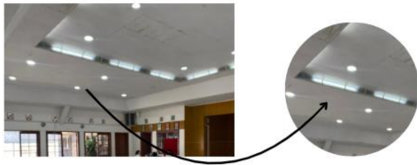
Gambar 3. 51 Material Plafond Pada Ruang Aula
